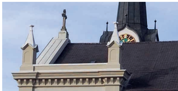
Die Türmchen der Pfarrkirche sind bereits saniert.
