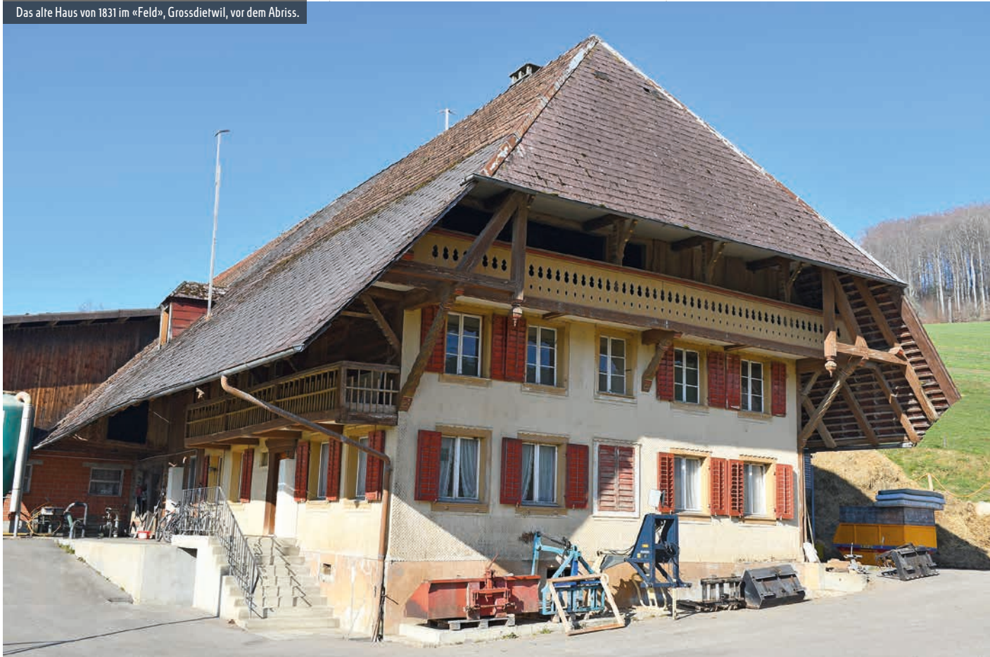
Das alte Haus von 1831 im «Feld», Grossdietwil, vor dem Abriss.
