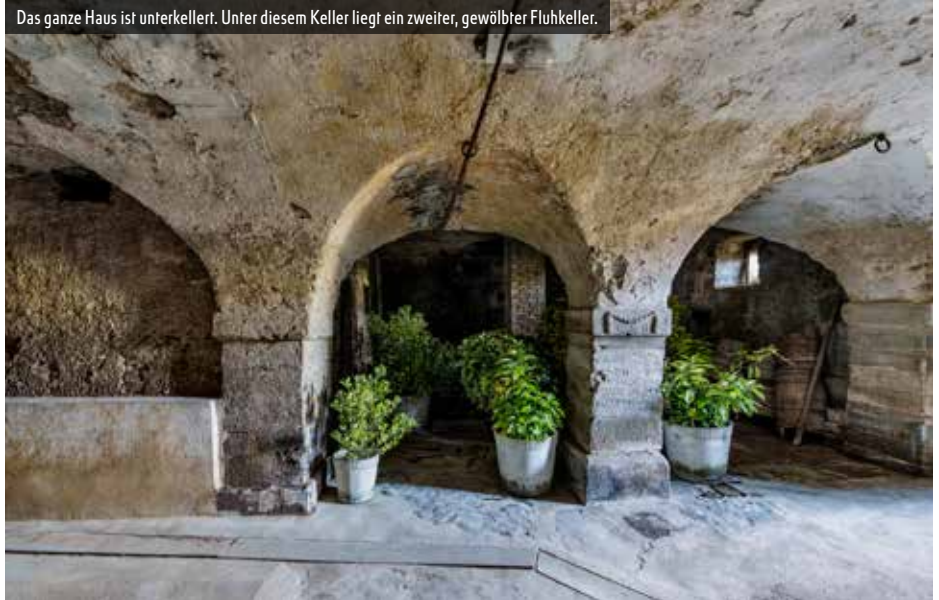
Das ganze Haus ist unterkellert. Unter diesem Keller liegt ein zweiter, gewölbter Fluhkeller.
